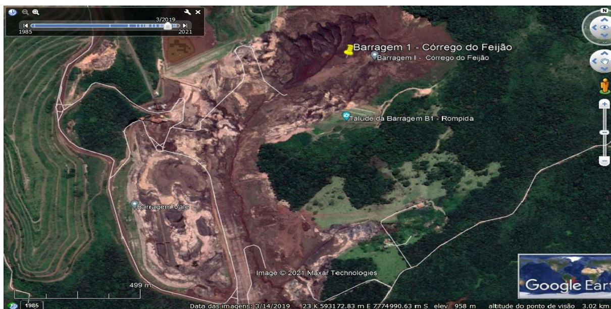
Figura 14 – Barragem no Distrito de Córrego do Feijão, Brumadinho-MG após o rompimento
