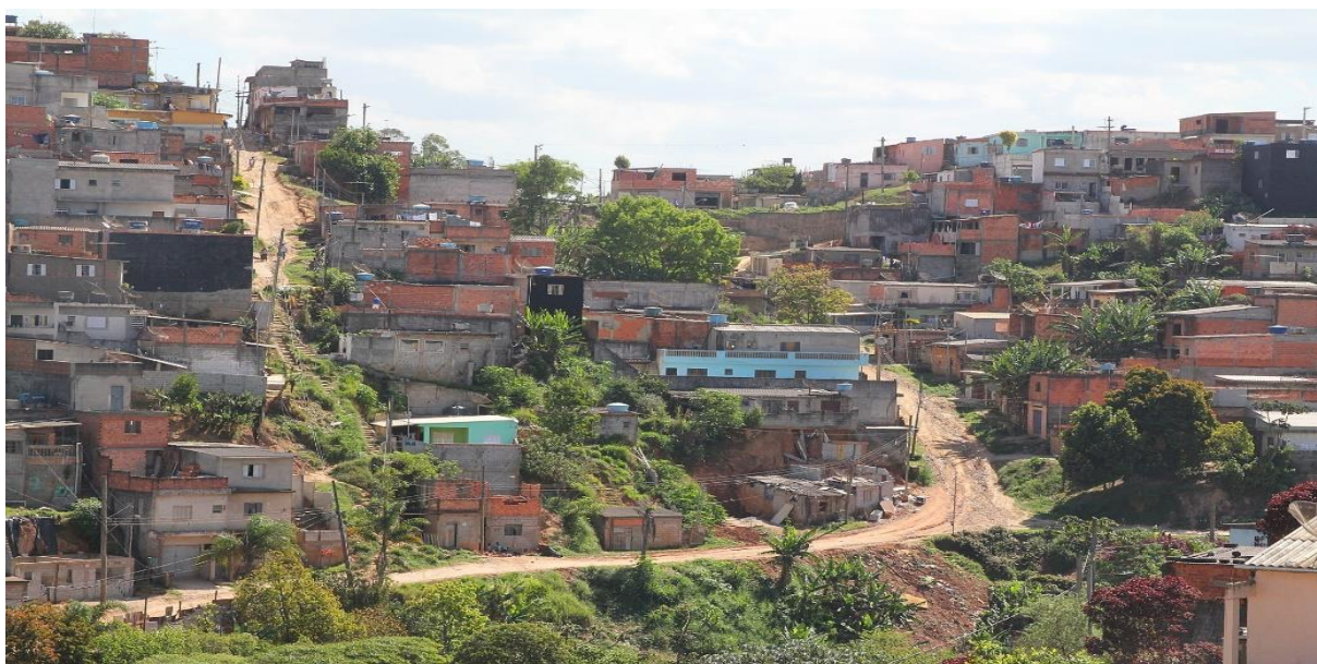
Figura 8 – Área de risco e ocupação irregular no Bairro Novo Recreio em Guarulhos – SP
