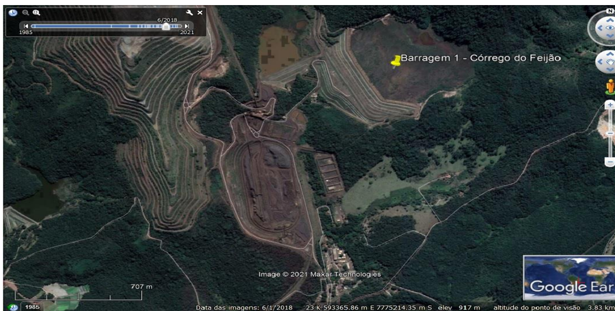
Figura 13 – Barragem no Distrito de Córrego do Feijão, Brumadinho-MG antes do rompimento
