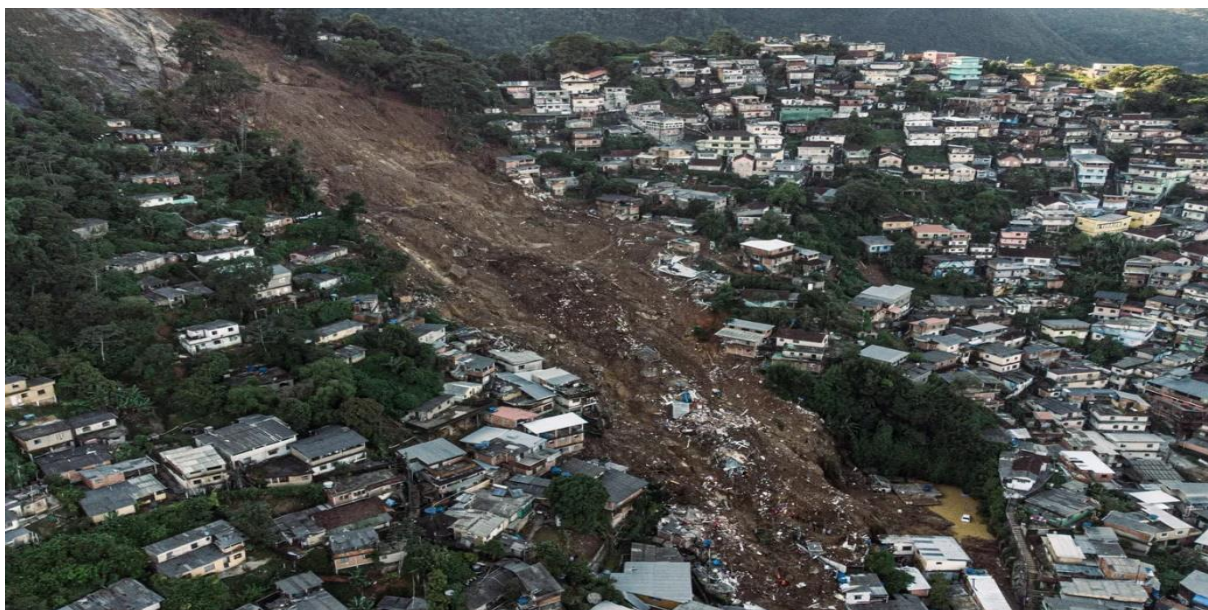
Figura 6 – Deslizamento planar de terra na comunidade do Morro da Oficina em Petrópolis RJ
