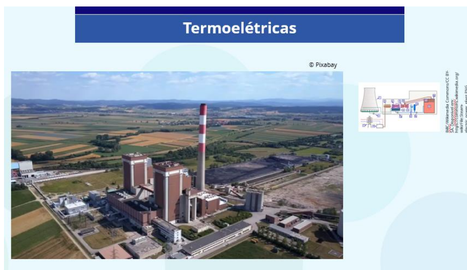
Figura 59. Slide 15. Geração De Energia Elétrica – Usinas.
