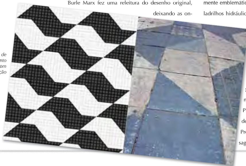
Figura 9 – À esquerda, proposta de Mirthes S. Pinto para o calçamento paulista e à direita o resultado com alguns anos de deterioração
