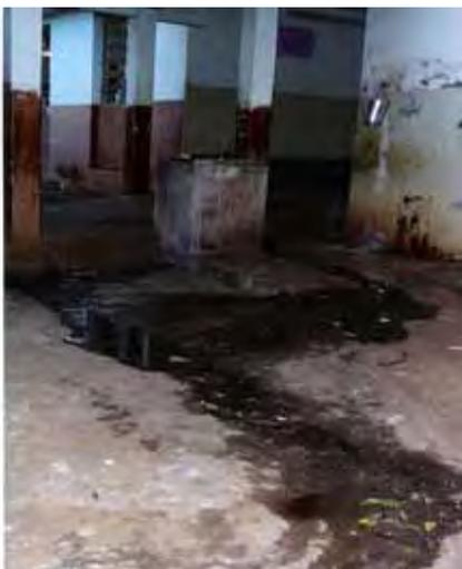
**Figura 4 - Foto do pátio da Escola onde se vê a água correndo fora dos canos do esgoto**
