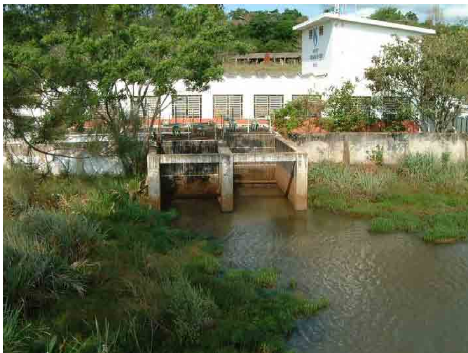
Figura 5. Área de captação da SABESP em Botucatu-SP.
