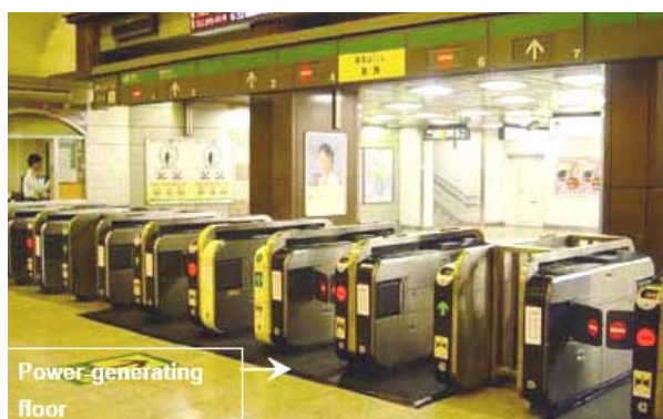
Figura 2.18. Piso gerador de energia implantado na Estação Marunouchi North Exit em Tokyo em 2006 (retirada do relatório da East Japan Railway Company).
