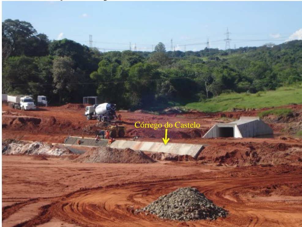
Foto 2 - Canalização do Córrego do Castelo
