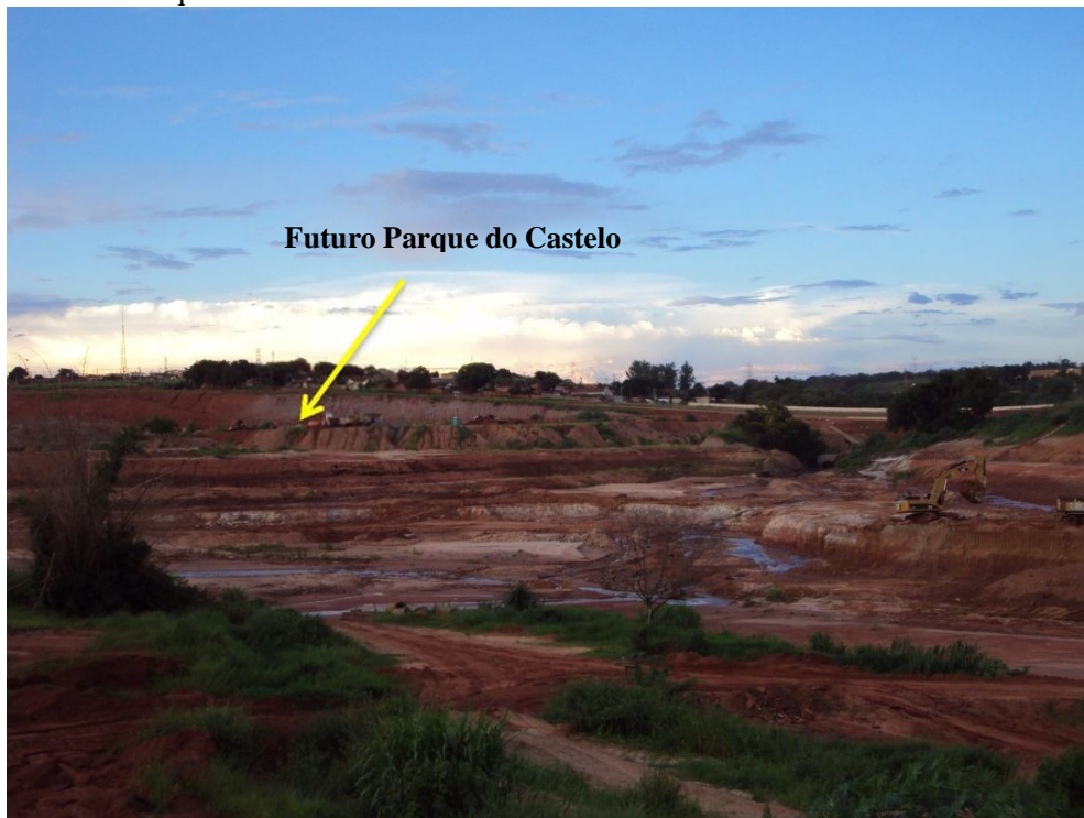
Foto 7 - Processo de construção da Avenida Nações Norte, com destaque ao fundo do Futuro Parque do Castelo.
