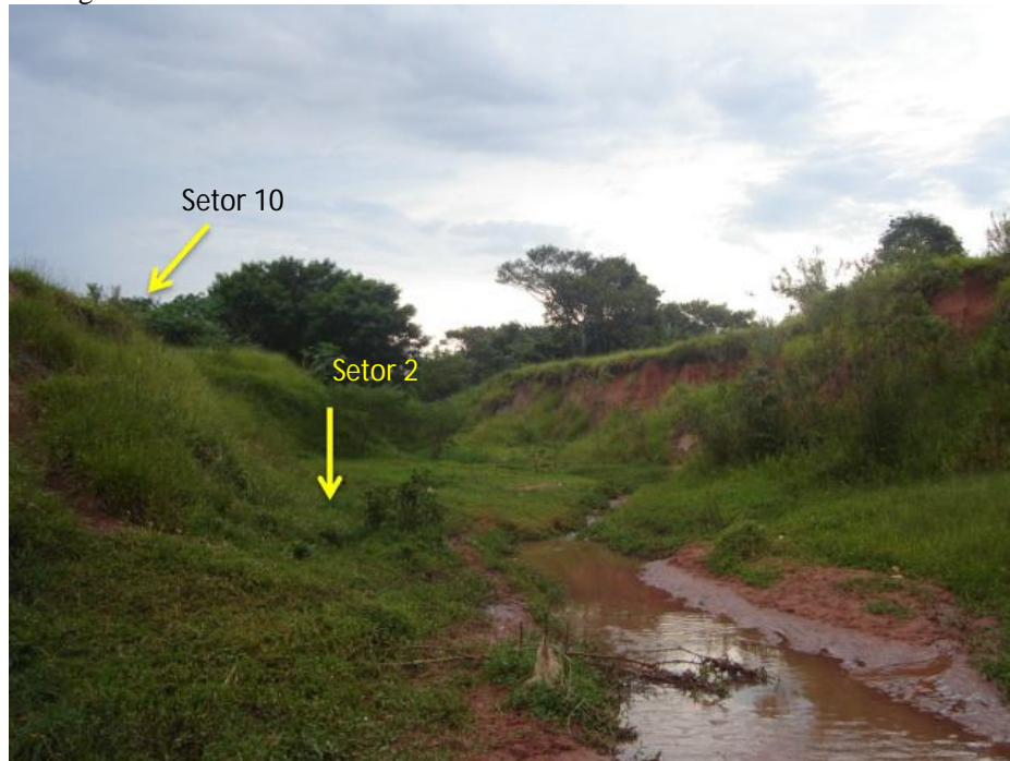
Foto 8 - Rupturas topográficas, no contato do Setor 2 com o 10, a montante do Córrego do Castelo.
