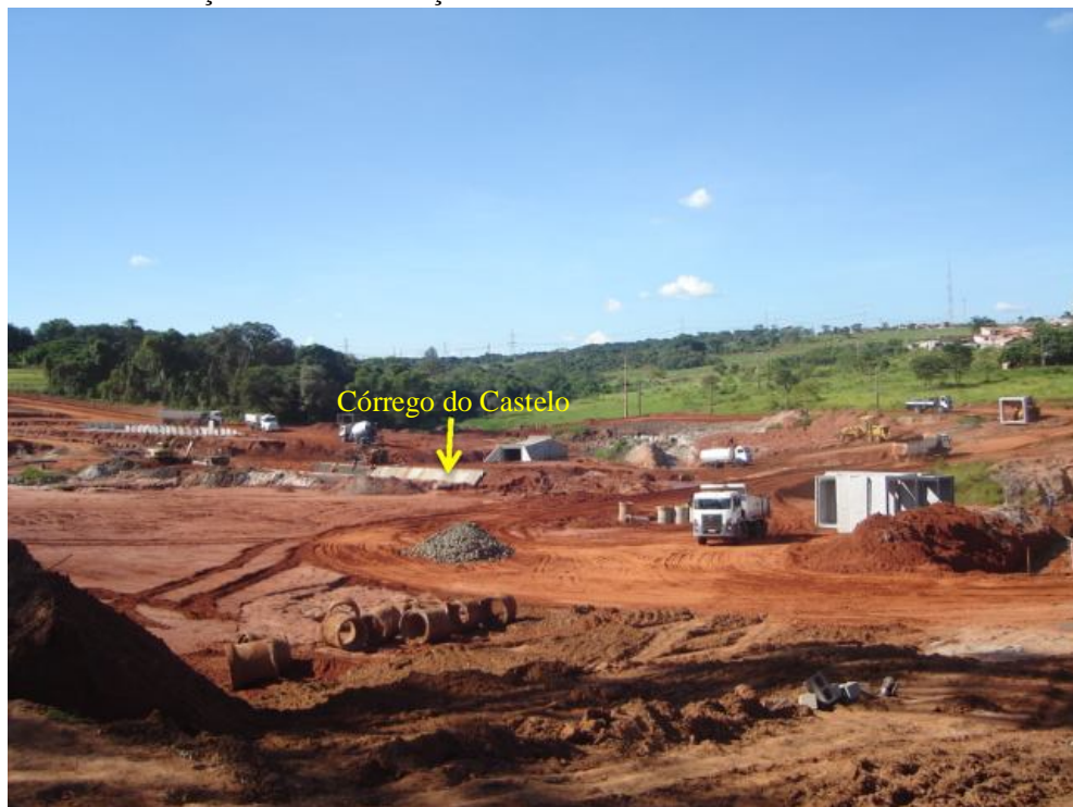
Foto 3 - Construção da Avenida Nações Norte
