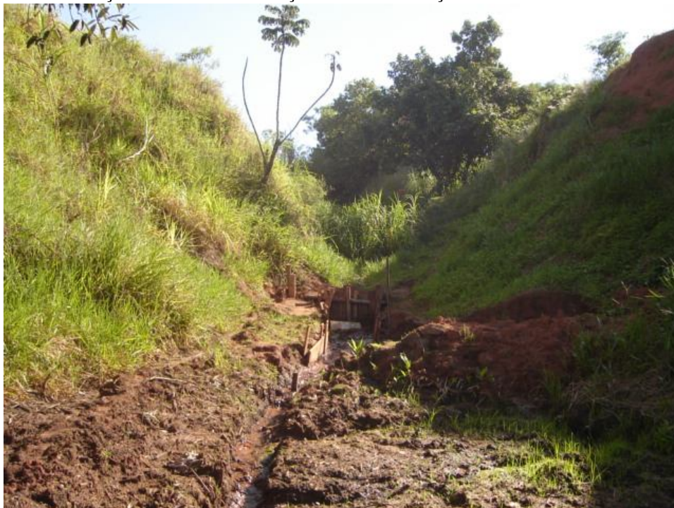
Foto 15 - Voçoroca antes da construção da Avenida Nações Norte.
