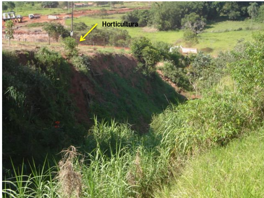
Foto 14 - Voçoroca no afluente na margem direita do Córrego do Castelo, presente no Setor 10.
