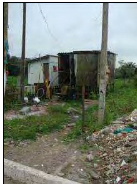
Figura 36D: Construções nas proximidades do rio Boturoca, em nível mais alto, a fim de evitar a invasão das águas nos períodos chuvosos. Unidade Geoambiental Terraços Marinhos Urbanizados em contato com a Unidade Fundos de Vale dos rios Branco ou Vargem Grande, Preto e Boturoca (Foto: Souza, 2010).
