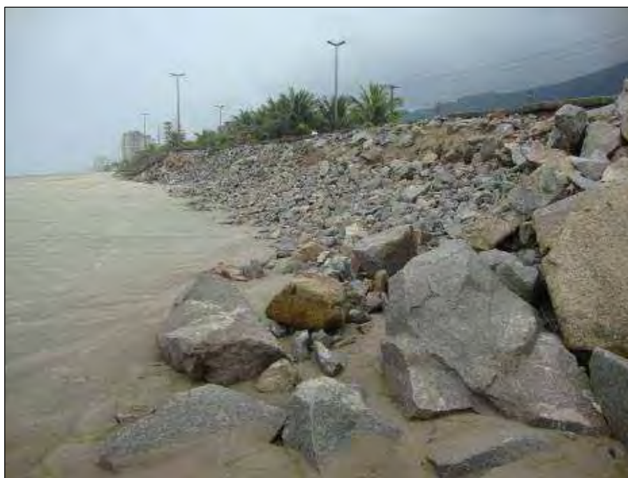
Figura 43: Tentativa de contenção da ação marinha no bairro Jardim Solemar, Unidade Geoambiental Planície Marinha Atual (Foto: Souza, 2010).
