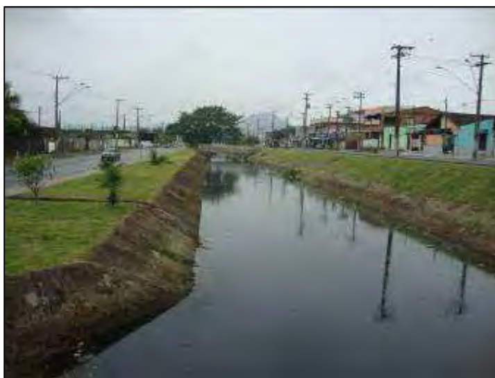
Figura 34B: Canalização e retificação de drenagem na Avenida do Trabalhador, Bairro Sítio do Campo, na Unidade Geoambiental Terraços Marinhos Urbanizados (Foto: Souza, 2010).
