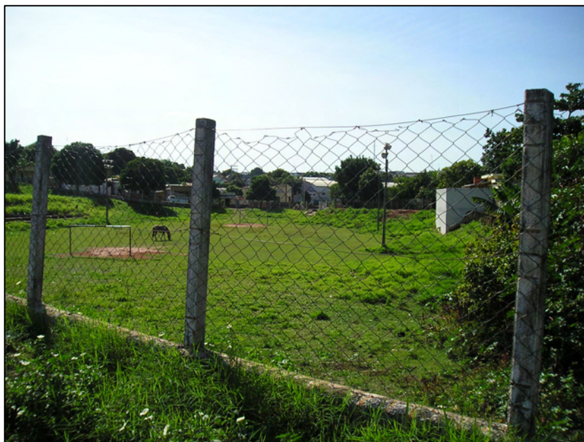
Figura 38 – Campo de futebol construído sobre o córrego canalizado da Rua José Siqueira - ocorrência de enchentes. Autora: Lima, v, dez/2005
