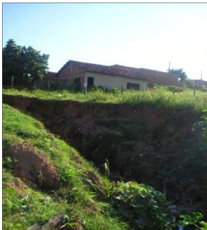
Figura 16 – Vista da vozoroca na área verde não efetivada nº 5, atrás da Praça Sebastião Zanetti, Bairro Jardim Santa Tereza próximo a residências. (Autora: LIMA, V. Dez/2005)
