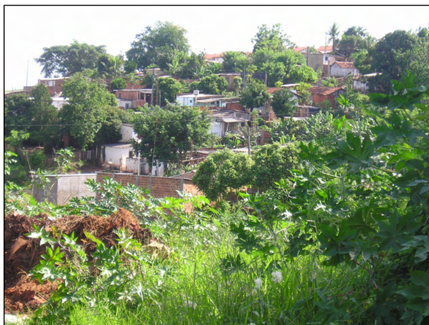
Figura 44 – Ocupação irregular e área de ocorrência de enchentes, próximo ao córrego afluente da Lagoa Mirim, bairro Vila Cavarú. Autora: Lima, V. dez/2005
