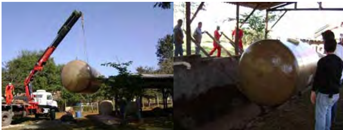
Figura 20: Instalação do reservatório de 10m 3 sobre o berço de areia, em 08/07/2011
