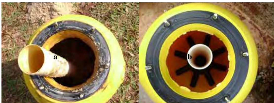
Figura 23: a) Retirada da areia do filtro previamente instalado b) filtro limpo sem meio filtrante, em 22/08/2011.
