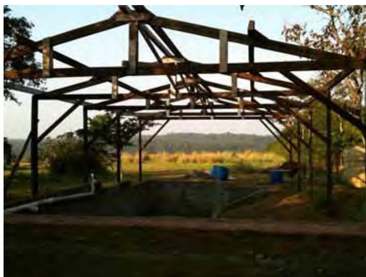
Figura 16: Estrutura de apoio do telhado, com tesouras e terças, em 22/06/2011
