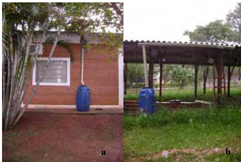
Figura 11: Reservatórios utilizados para coletar águas pluviais do telhado cerâmico (a) e de fibrocimento (b)
