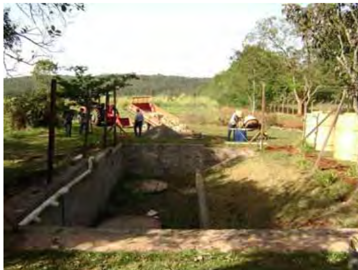
Figura 14: Instalação da estrutura de apoio do telhado, em 08/06/2011
