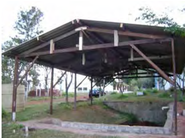
Figura 17: Telhado completamente instalado, em 30/06/2011
