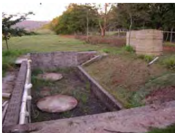
Figura 13: Retirada dos reservatórios com capacidade de 3m 3 cada, em 31/05/2011
