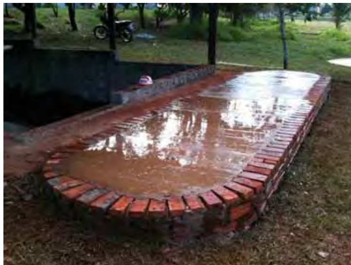
Figura 18: Base de tijolos e concreto para os três reservatórios de 3m 3 cada, em 07/07/2011
