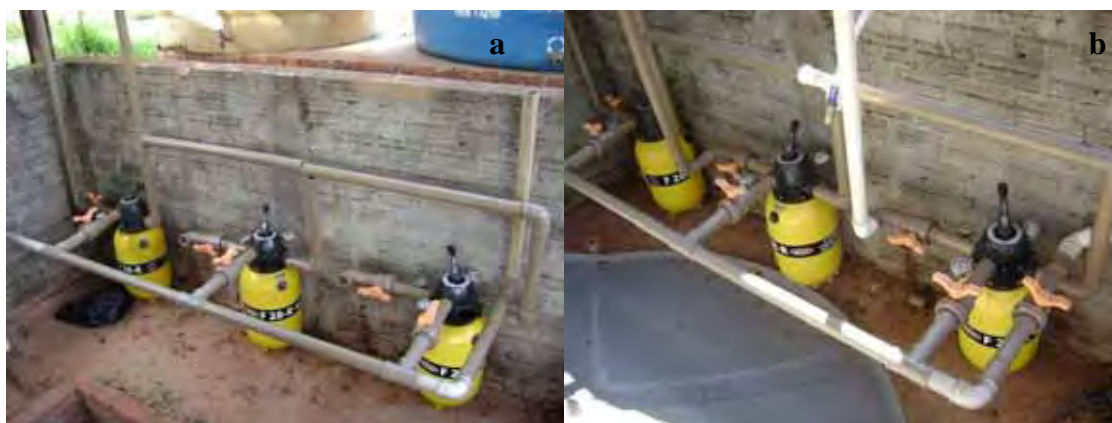
Figura 25: a) Início das instalações das tubulações dos filtros, em 29/08/2011; b) filtros instalados, em 19/09/2011
