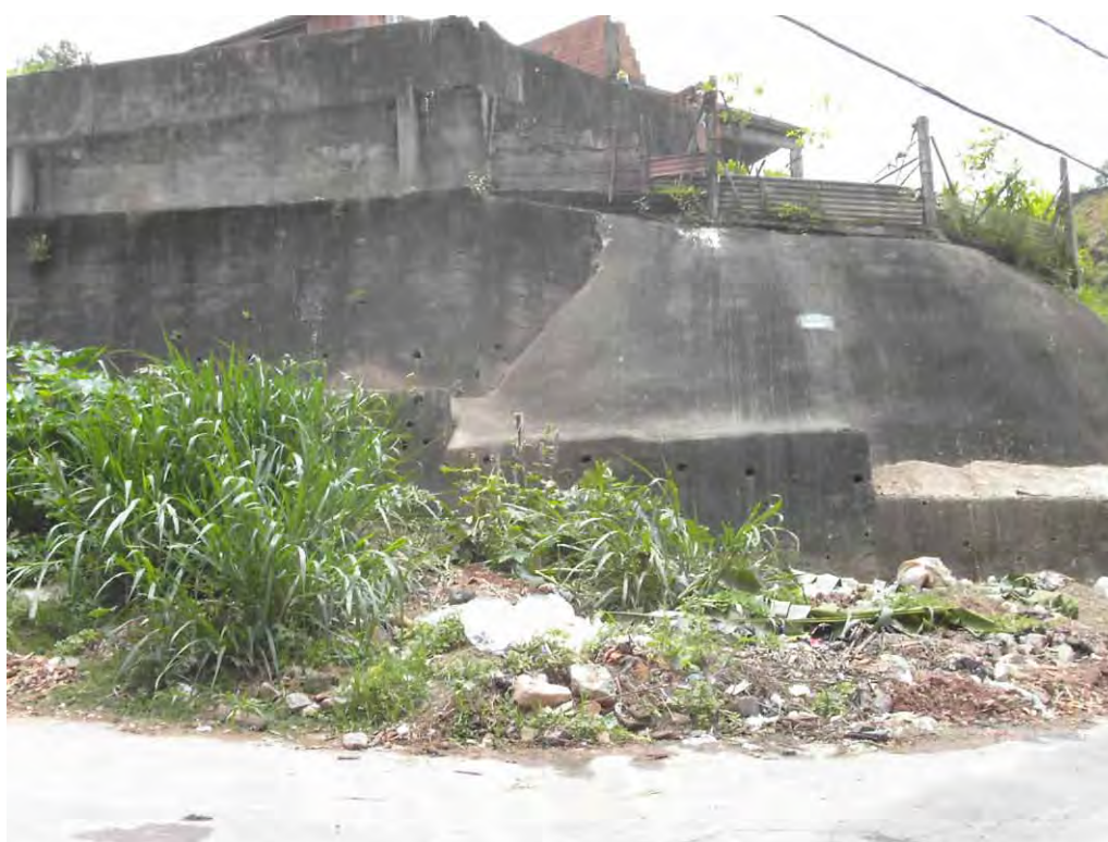
Fotografia 6: Estrutura de contenção (na parte inferior, à direita, reparo com cimento feito pelos próprios moradores) e presença de lixo e entulho na esquina da Rua da Esperança com a Rua da Fé. Lucas B. Souza, dezembro/2005.
