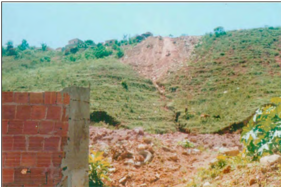
Fotografia 10: C - Encosta com lixo e entulho depositados e erosão na base. Bairro Santa Rita (Lot. Antônio Brum), Juiz de Fora (MG). Defesa Civil de Juiz de Fora, sem data.
