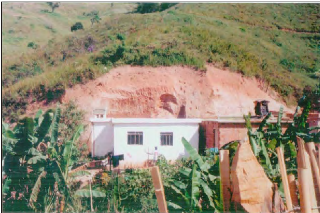
Fotografia 9: B - Ocupação em área de corte com geometria inadequada e sem contenção; solo exposto. Bairro Santa Rita (leito da E. F. Leopoldina), Juiz de Fora (MG). Defesa Civil de Juiz de Fora, sem data.
