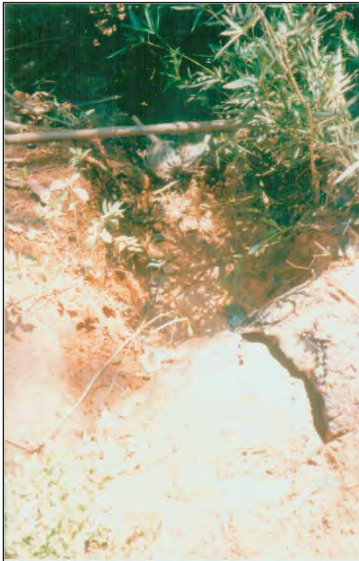
Fotografia 11: D - Manilha rompida, com vazamento de água ou esgoto. Bairro Vale do Ipê, Juiz de Fora (MG). Defesa Civil de Juiz de Fora, sem data.
