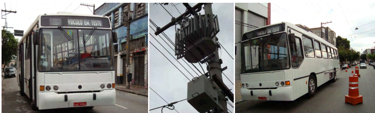
Figura 5.24: Início da linha experimental em CA e local onde o transformador foi instalado (Rua Oriente, 124), de onde é alimentada a linha CA experimental.
