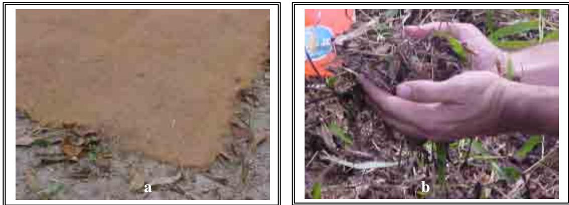
Figura Va e Vb – Manta já assentada e fixa sobre o solo, onde é possível verificar nas bordas um pouco da serapilheira depositada (a), que foi extraída dos remanescentes do entorno (b).
