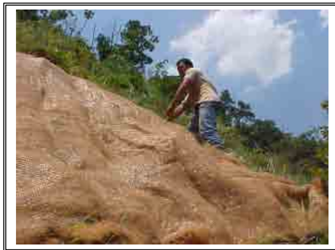
Figura VI – Manta instalada em janeiro de 2004 na área 2.
