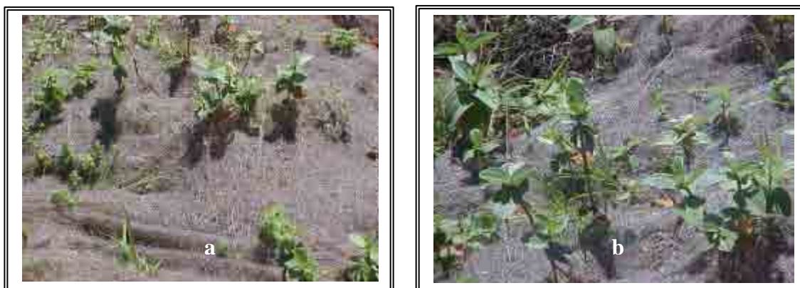
Figuras VIIIa e VIIIb – Regeneração natural sobre a manta 6 meses após a instalação na área 1.
