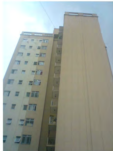
Figura 43 - Fachada do edifício
