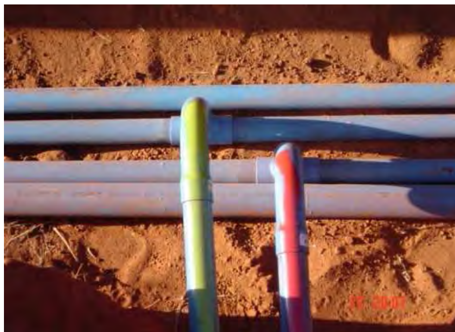
Figura 4. Tubulações de polietileno e linhas de distribuição de água
