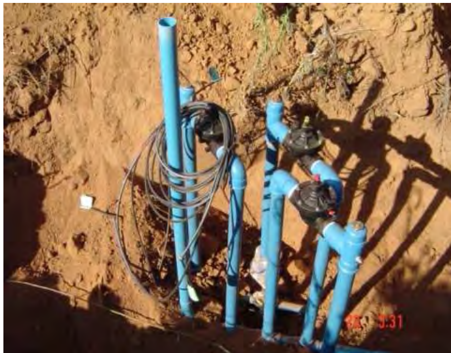
Figura 3. Cavaletes, válvulas e micro tubos de automação dos setores de irrigação
