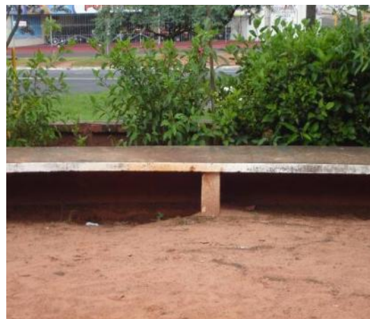
Figura A-4 – Banco de concreto do playground
