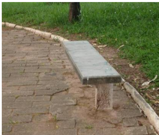
Figura A-3 – Banco de concreto da área de bancos
