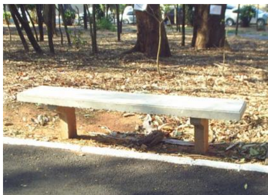
Figura A-9 - Banco de concreto sem encosto
