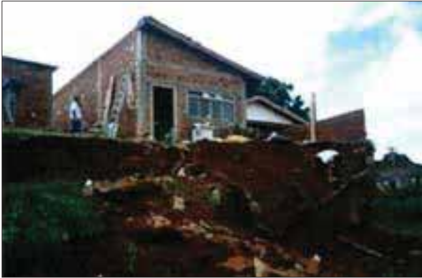
Foto 5: Muro de arrimo derrubado pela enxurrada.
