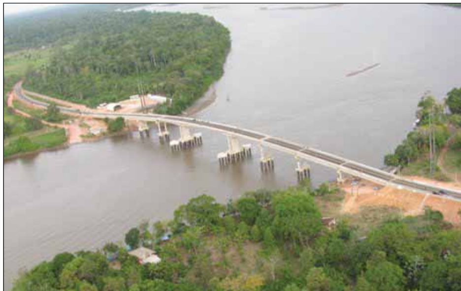
Foto 15: Ponte sobre o rio Vila Nova Fonte: Araújo (Dez. 2010)
