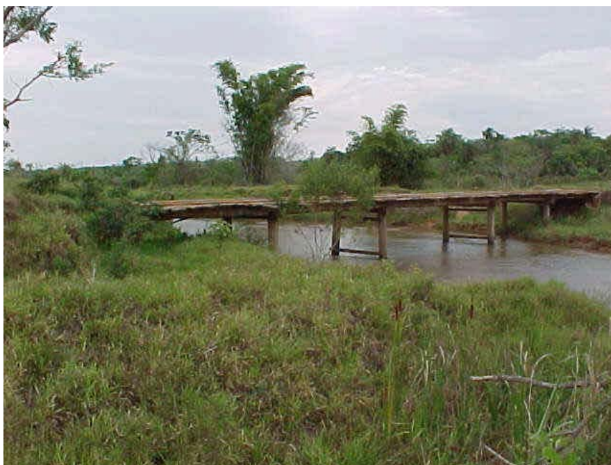
Foto 18: Ponte em estrada rural de madeira e abandonada (lato curso do ribeirão).Torres, 2001.
