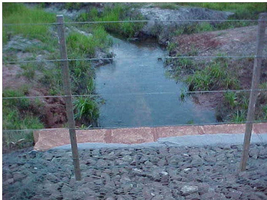
Foto 61: Córrego do Segredo: bueiro com muro de arrima, para contornar o problema provocado pela elevação de suas águas. Acesso à Fazenda Boa Sorte, Município de Anaurilândia/MS. Passos, 05/01.
