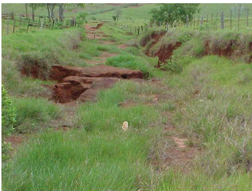
Foto 7: Esta antiga estrada rural no alto curso do ribeirão é um exemplo gritante da “desativação” econômica atual a qual a área passa. Nota-se, inclusive, processo acelerado de erosão. Passos, 2001.
