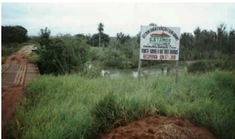
Foto 49: Ribeirão Três Barras e ponte de madeira a fim de viabilizar acesso ao município de Anaurilândia e também às áreas e lazer. Em breve será construída ponte de concreto de acordo com o programa de “Obras compensatórias” da CESP. Torres, 2001.
