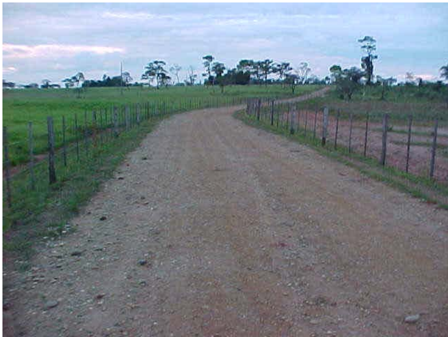
Foto 60: Devido a elevação do nível de base regional – Rio Paraná – para 257m, após o enchimento do reservatório da UHE Eng. Sérgio Motta, vários cursos de água regionais foram alterados, alagando estradas que davam acesso à propriedades rurais. A fim de compensar este prejuízo à população sul-mato-grossense, a CESP construiu significativos trechos de aterros elevados capeados com cascalhos, de modo a manter a circulação normalizada. Torres, 2001.
