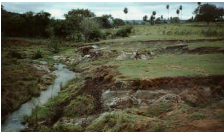
Foto 48: Margem esquerda do alto curso do córrego Peleja, com erosão, lixiviação do solo, ausência de mata ciliar e terraço fluvial hidromorfizado que está bastante comprometido pela erosão provocada pelo pisoteio do gado ao buscar acesso à água. Torres, 2001.
