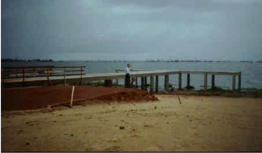
Foto 59: Área em que está sendo construído um pesqueiro em Anaurilândia em decorrência do acordo da CESP para realização de obras compensatórias. Torres, 2002.
