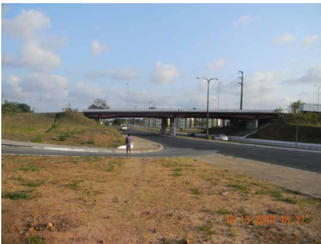
Foto 47 – Vista do viaduto do bairro Radional numa área de tabuleiro com topo convexo e vertente côncava - ponto 5 do perfil AB Fonte - Silva, 2010.
