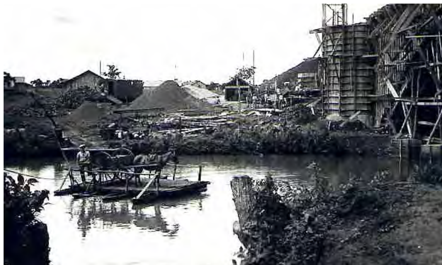
Figura 16 - Trecho da NOB em construção
