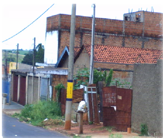
Foto 6. Improviso na proteção do imóvel
