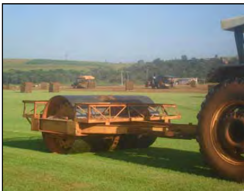
Figura 8. Rolo compactador de superfície lisa utilizado após a irrigação.
