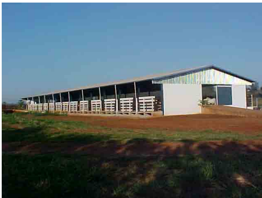
Figura 1. Vista geral do confinamento.
