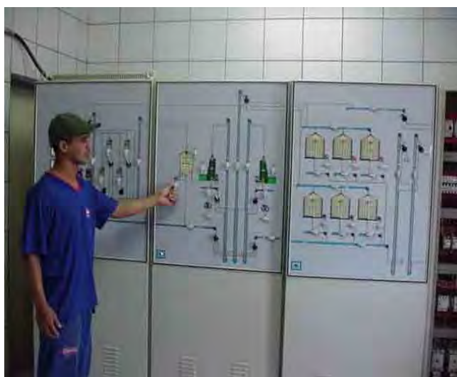
Figura 30 - Quadro de proteção e comando dos motores de aeração
