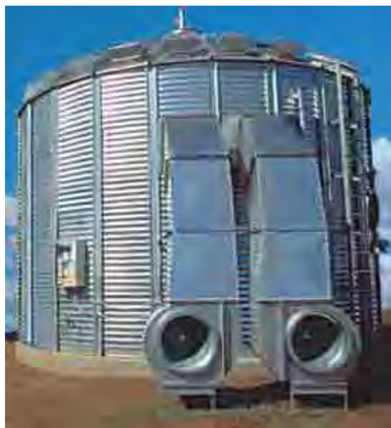
Figura 8 - Silo metálico, plano, vertical - secador de grãos
