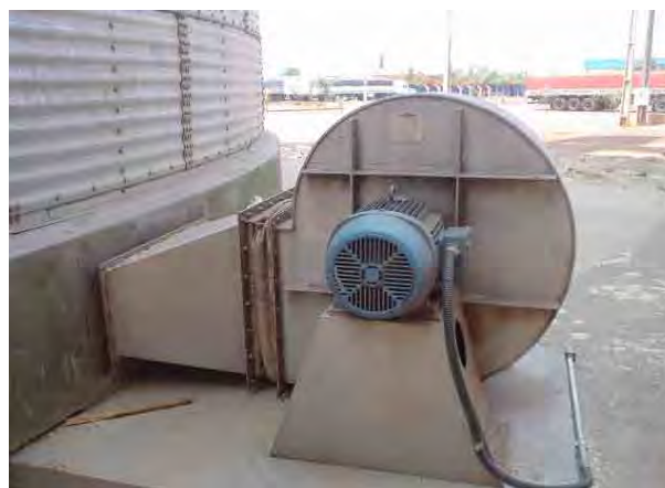
Figura 29 - Aerador (conjunto motor-ventilador)
