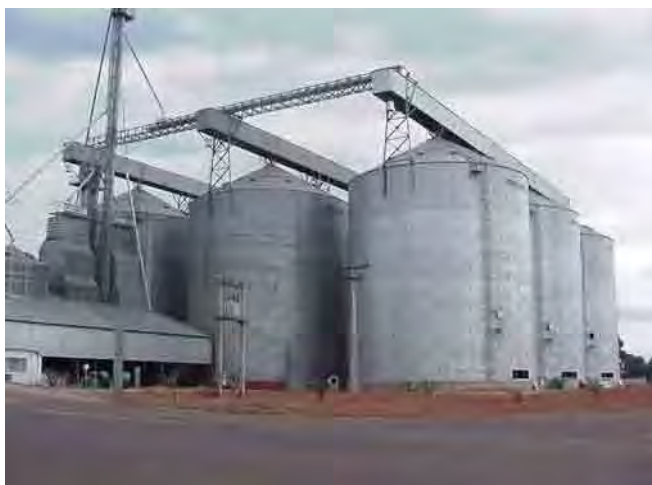
Figura 28 – Silos planos metálicos verticais
