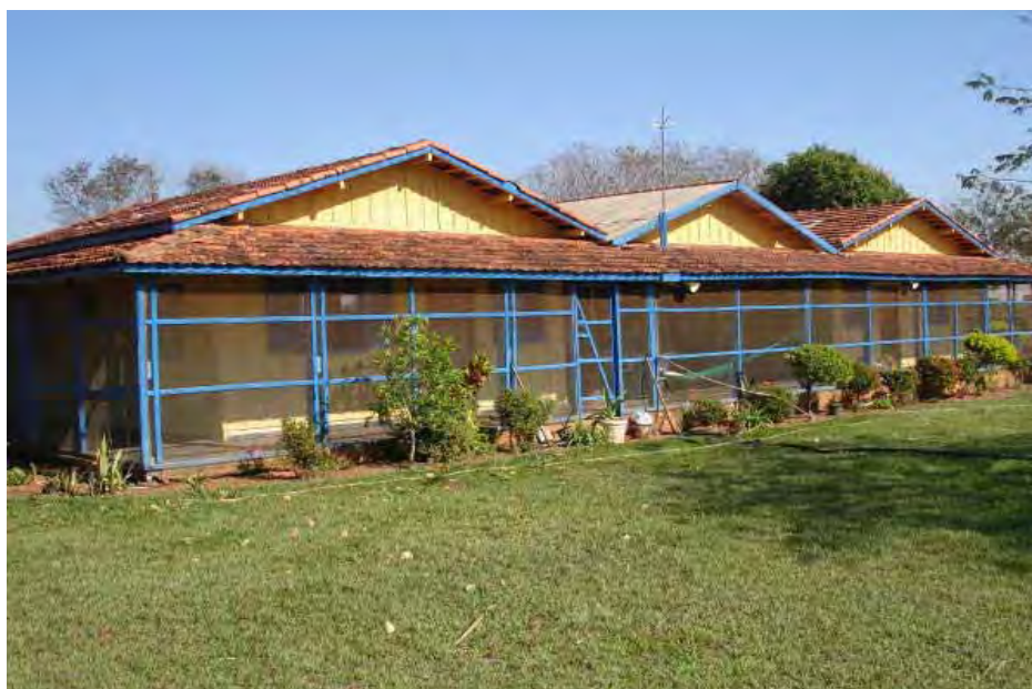
Figura 23 - Casa sede da Fazenda Madeira (2007).
