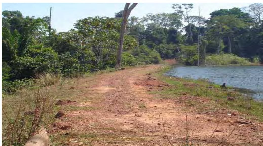
Figura 25 - Barragem existente na Fazenda Madeira (2007).
