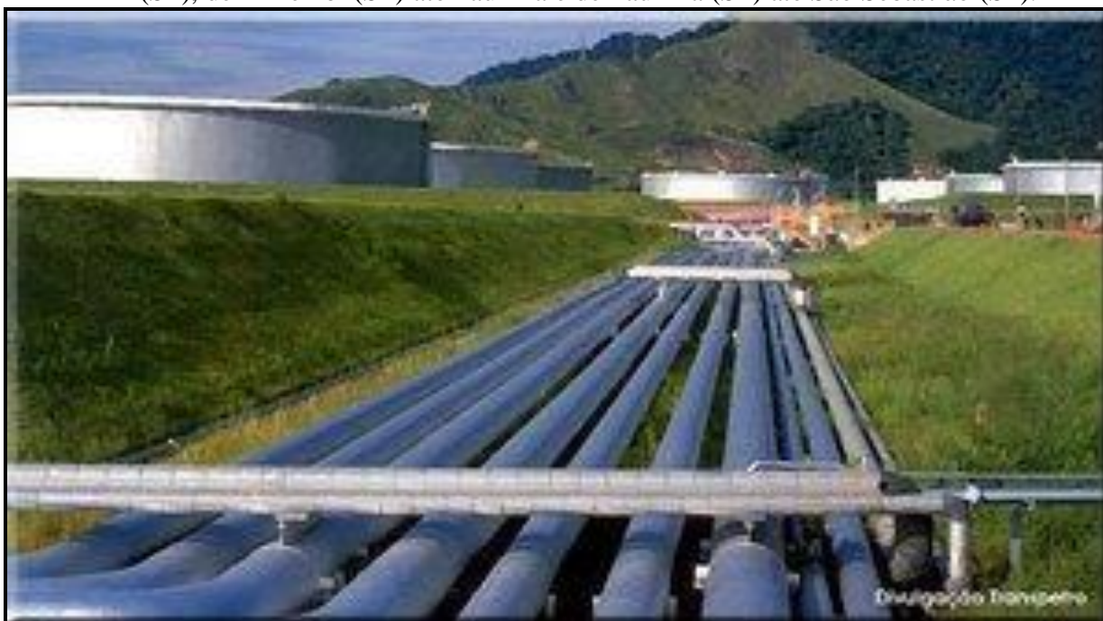
Figura 19 - Foto-exemplo de um sistema de dutos e tanques, que armazenariam e transportariam etanol por dutovia de Aparecida do Taboado (MS) até Paulínia (SP), de Anhembi (SP) até Paulínia e de Paulínia (SP) até São Sebastião (SP).
