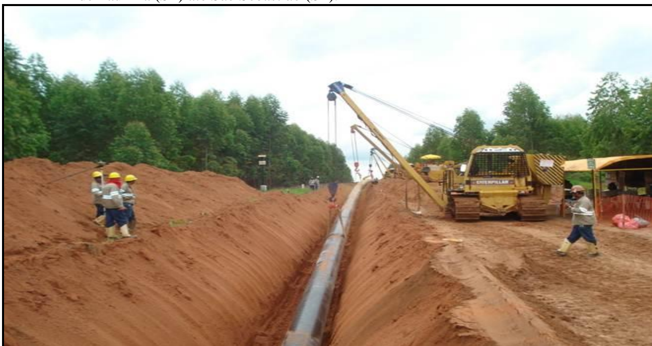
Figura 24 - Sistema de dutos sendo construído, que transportaria etanol por dutovia de Aparecida do Taboado (MS) até Paulínia (SP), de Anhembi (SP) até Paulínia e de Paulínia (SP) até São Sebastião (SP).
