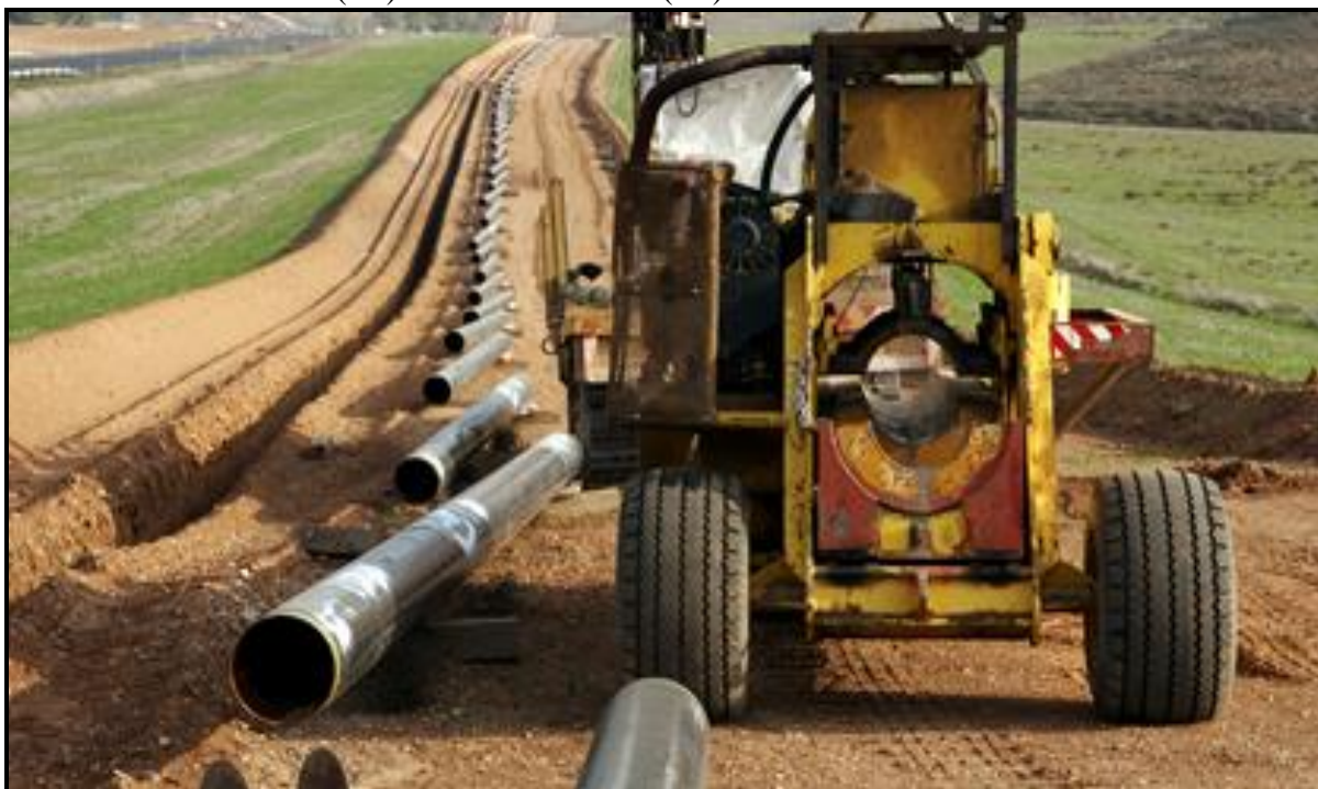
Figura 23 - Sistema de dutos sendo construído, que transportaria etanol por dutovia de Aparecida do Taboado (MS) até Paulínia (SP), de Anhembi (SP) até Paulínia e de Paulínia (SP) até São Sebastião (SP).
