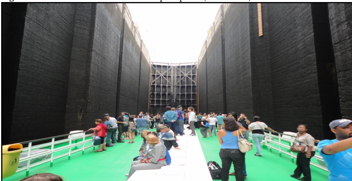
Figura 18 - Portão de eclusa a montante tipo esporão (duas folhas).
