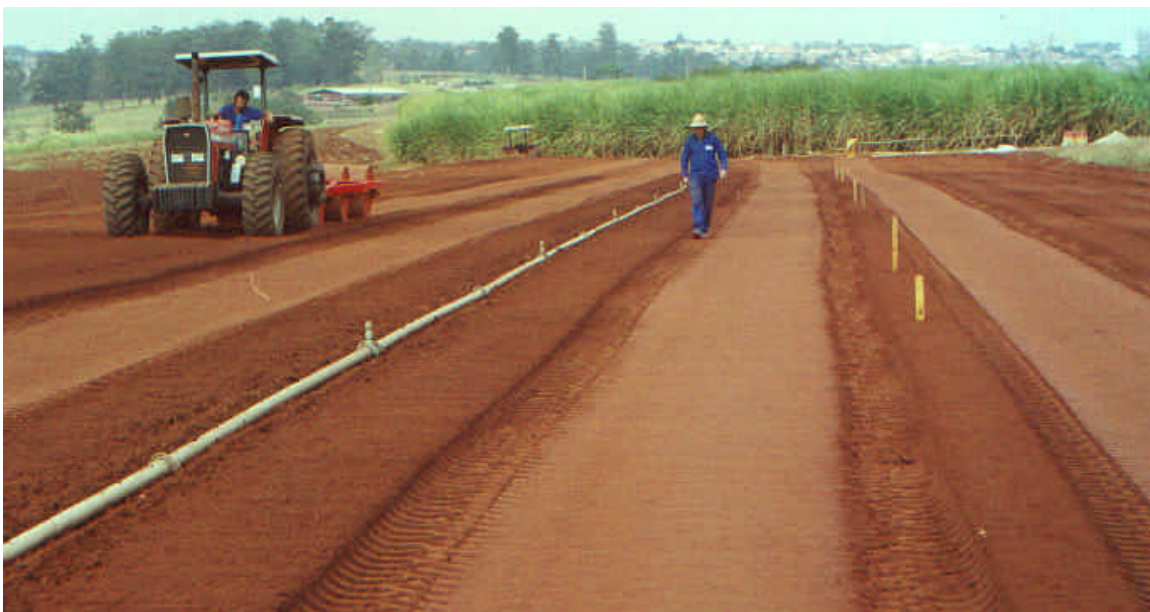
Figura 22: Vista da área experimental sendo preparada para o ensaio de campo.
