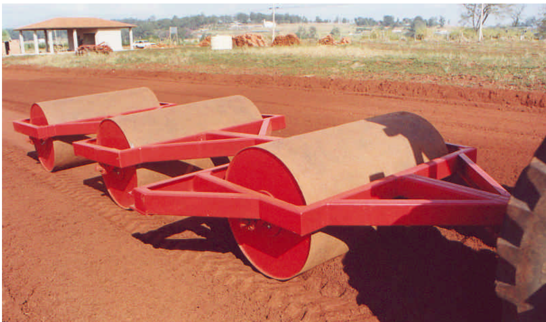
Figura 21: Compactação de uniformização da área experimental.
