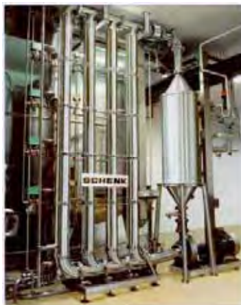
Figura 4. Planta industrial para processamento de cerveja com área de filtração de 72 m 2 (Dortmunder Actien-Brauerei) [67].
