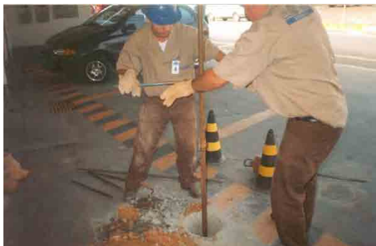
Figura 3.3 - Realização da sondagem com trado rotativo manual (Posto SB).
