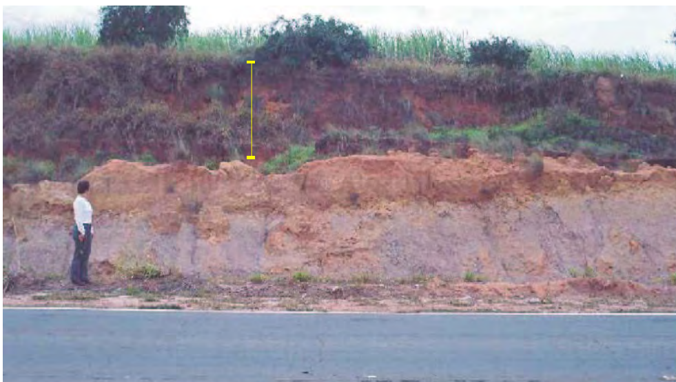
Foto 14. Perfil 5 (indicado), parcialmente encoberto por vegetação.
