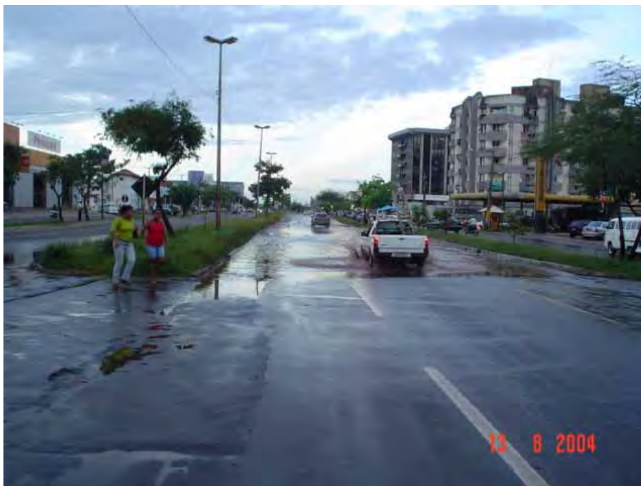
Foto 2 – Vista geral da unidade I, com detalhe de alagamento na Av. dos Africanos, após chuva intensa ( Ponto G-160, Apêndice A).
