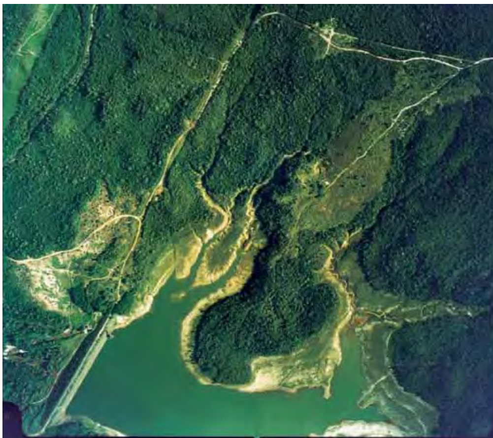
Foto 1 - Vista parcial do Reservatório Batatã (Prefeitura Municipal de São Luís, 2002).
