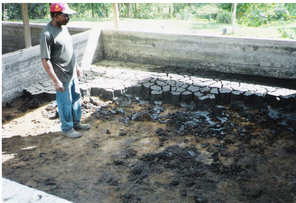
Fig. 5 Tanque de secagem do lodo, Curtume Finipelli, Patrocínio Paulista/SP.
