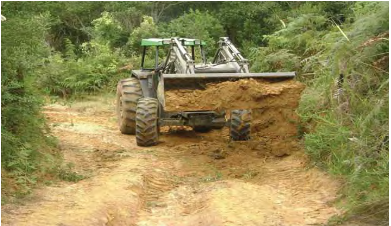
Figura18 – Remoção da vegetação para abertura da frente de lavra.
