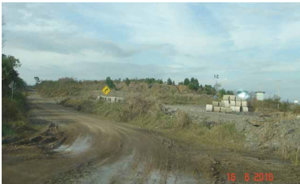
Figura 20– Obras de infra-estrutura necessárias a abertura da frente de lavra.
