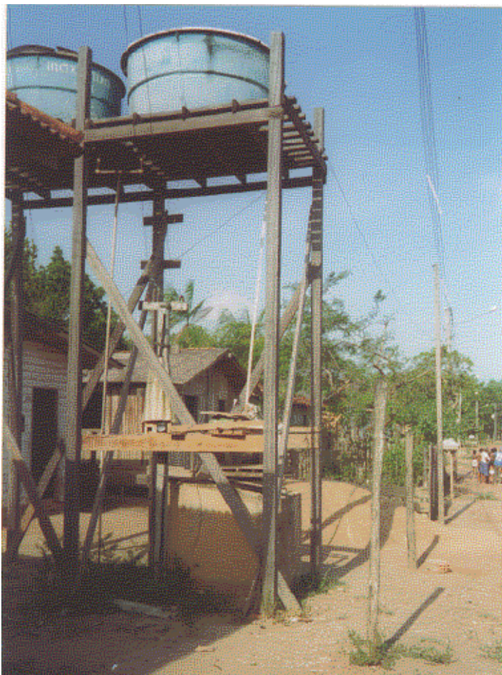
Foto 4.5 – Poço amazonas comunitário utilizado para consumo de água por moradores da Vila do Elesbão, próximo à área industrial da ICOMI.
