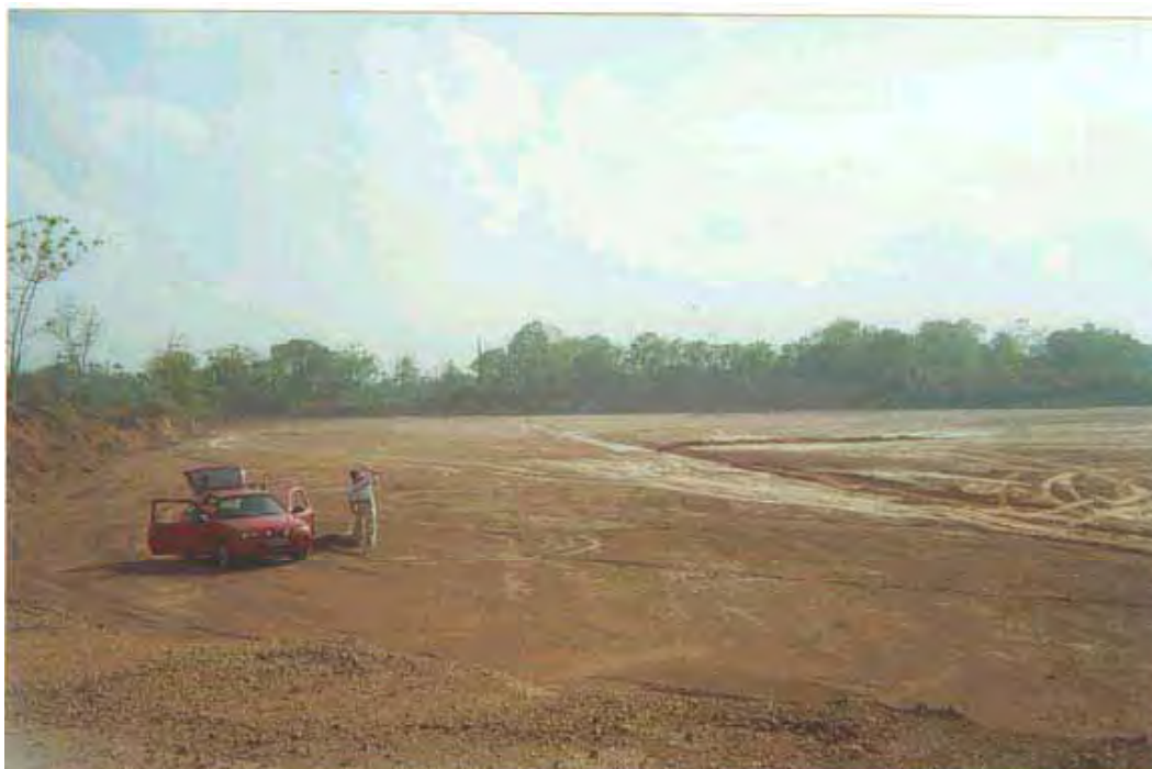
Foto 4.1 – Vista parcial da Bacia de Rejeitos onde eram depositados os resíduos de manganês provenientes das usinas de pelotização/sinterização. A Bacia foi limpa e aterrada pela ICOMI.
