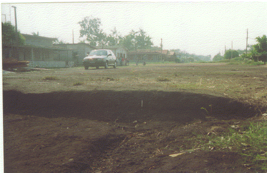
Foto 4.4 – Uma rua do bairro da Hospitalidade no bairro comercial de Santana e próximo ao Igarapé Boiero, aterrada com rejeitos de manganês. Uma fina camada de piçarra foi colocada por cima dos rejeitos.
