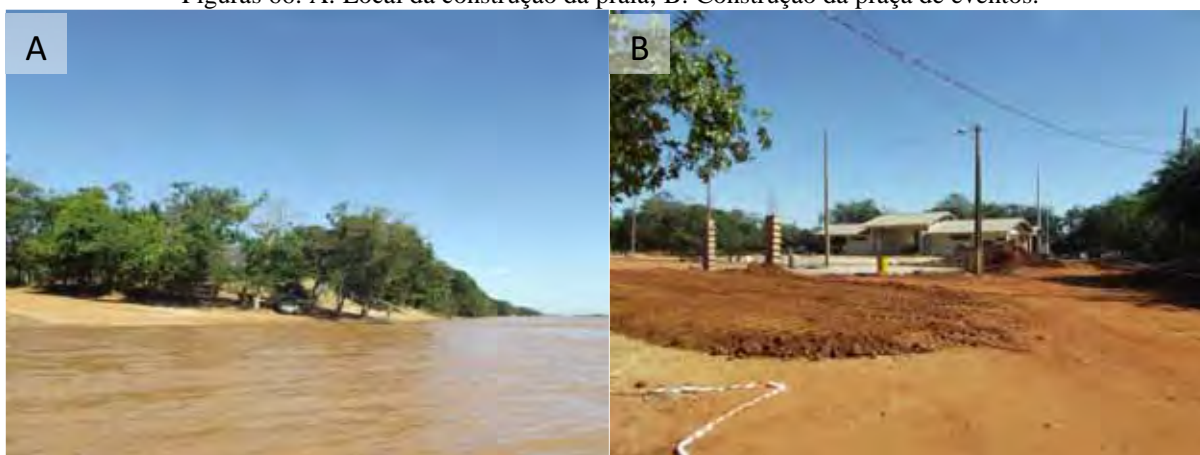
Figuras 66: A: Local da construção da praia; B: Construção da praça de eventos.
