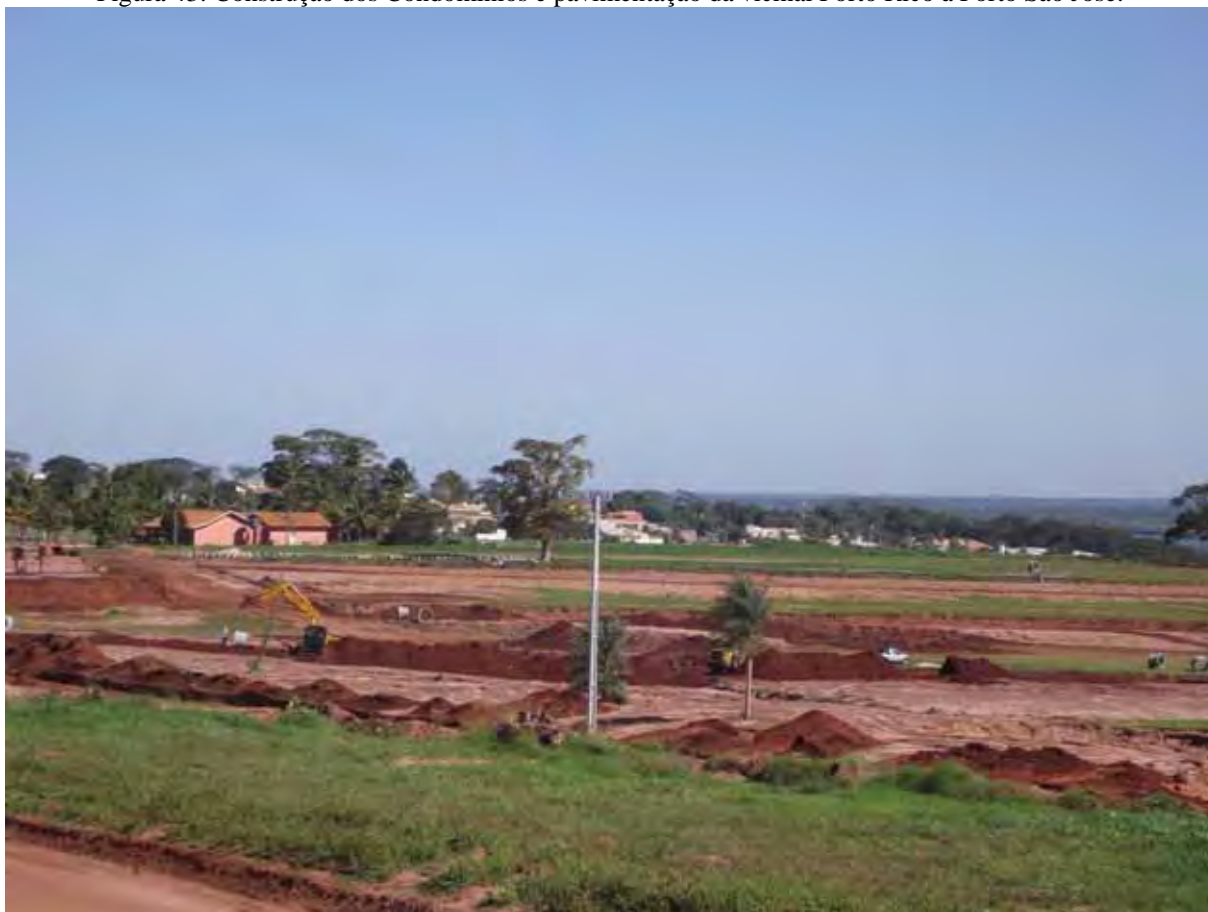
Figura 43: Construção dos Condomínios e pavimentação da vicinal Porto Rico à Porto São José.
