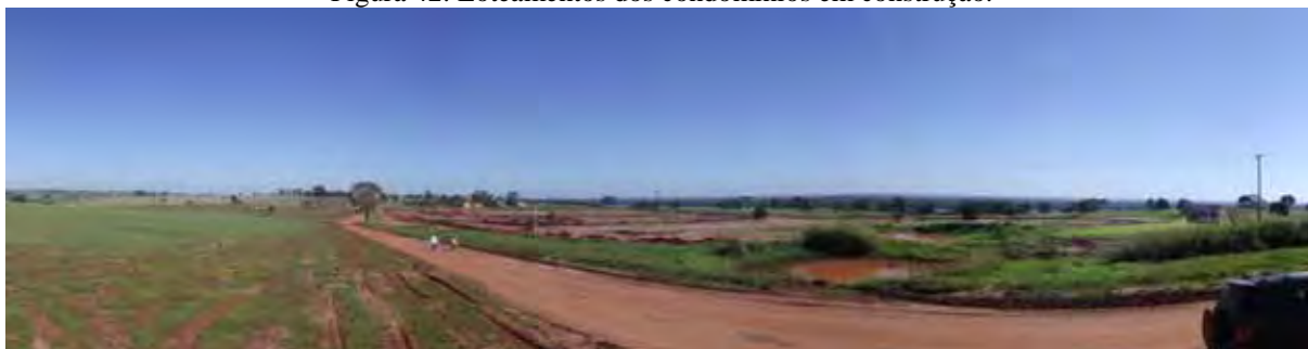
Figura 42: Loteamentos dos condomínios em construção.
