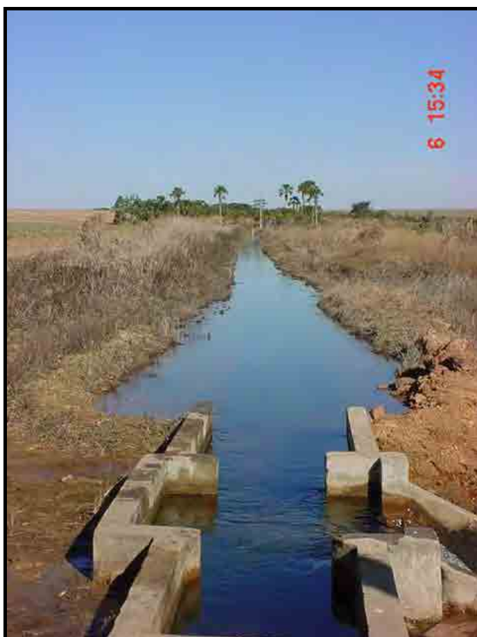
Foto 26 – Após o represamento das nascentes da vereda foi construído um canal de drenagem para captação da água para ser utilizada na irrigação. Distrito de Santo Antônio do Rio Verde (Sudeste Goiano).
