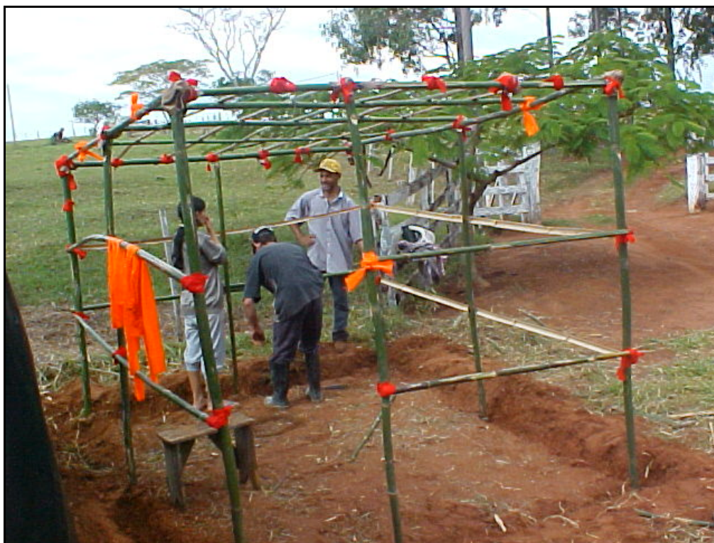
Figura 6: Família sem terra construindo o barraco no Acampamento – MST, município de Marabá Paulista. A ocupação e a constituição do acampamento são, como os restantes momentos da luta, ações que as famílias realizam comunitariamente. Acampamento, no município de Marabá Paulista.
