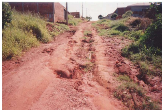
Figura 19 – Rua sem pavimentação
