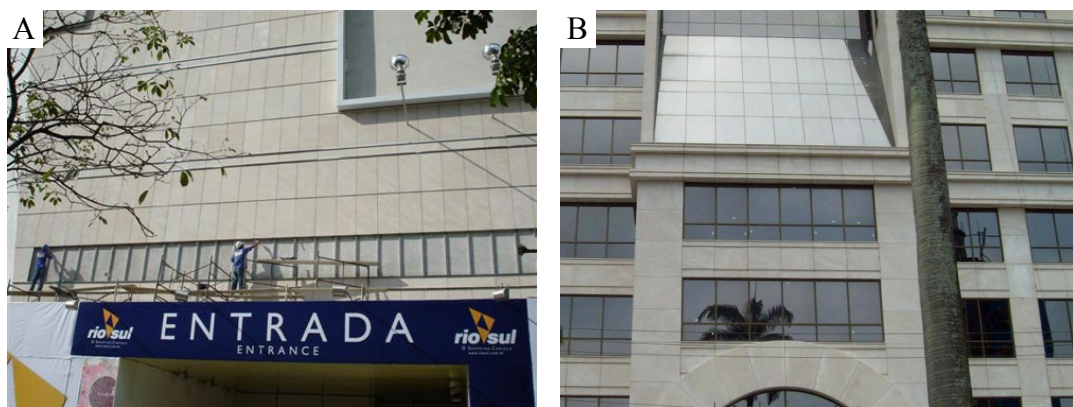
Figura 3.3 – Utilização do calcário Mont Charmot em fachadas de prédios.
