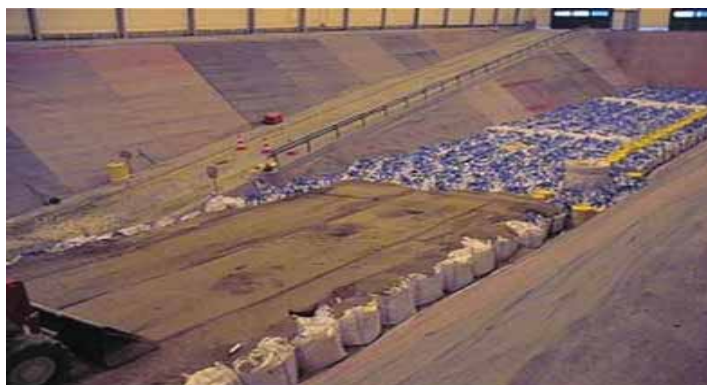
Figura 01. Instalação de disposição de rejeitos de muito baixo nível de radiação em Morvilliers , no noroeste da França (IAEA, 2011b).
