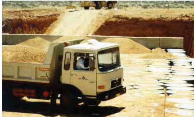
Figura 12. Cobertura dos tanques com argila (NLM, 2005).
