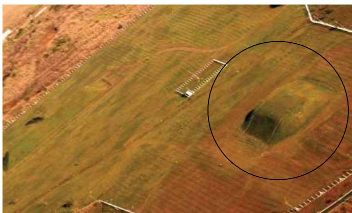
Figura 05. Foto aérea do repositório de rejeito do acidente de Goiânia em Goiás - círculo (TOMAZ, 2011).
