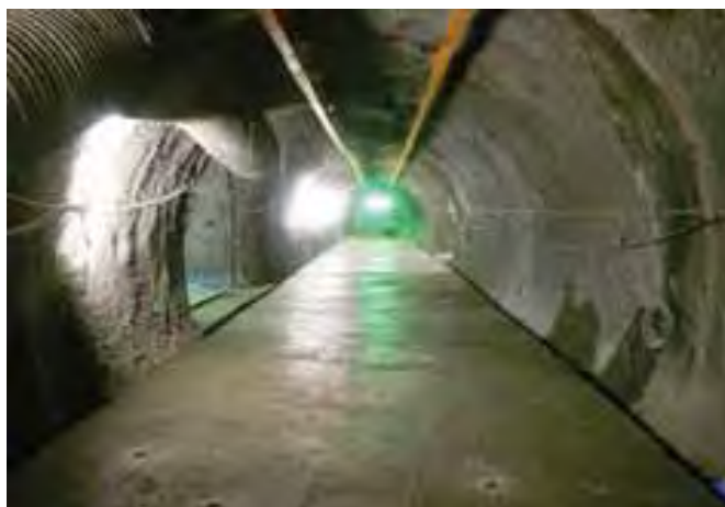
Figura 26. Detalhe do túnel de investigação no URL de Horonobe , província de Hokkaido no Japão, com medidas de 3 metros de altura – do teto ao solo - e 4 metros de largura (JAEA, 2011b).
