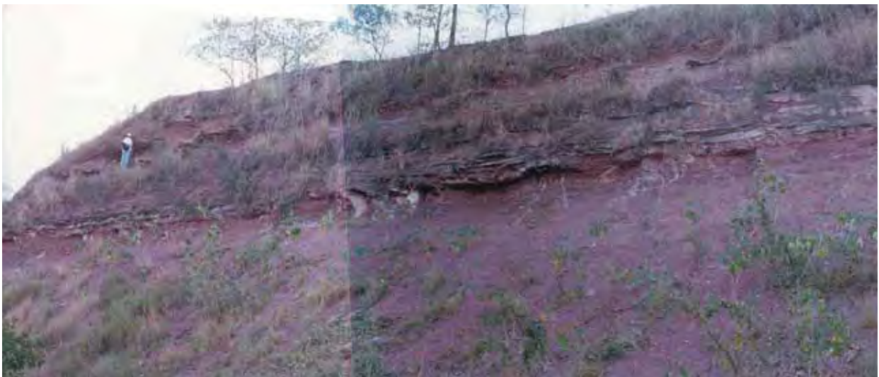
FIGURA 19. VISTA GERAL DO AFLORAMENTO LOCALIZADO NA RODOVIA SP 191.
