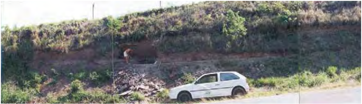
FIGURA 21. VISTA DO AFLORAMENTO LOCALIZADO NA RODOVIA RAPOSO TAVARES, KM 209.
