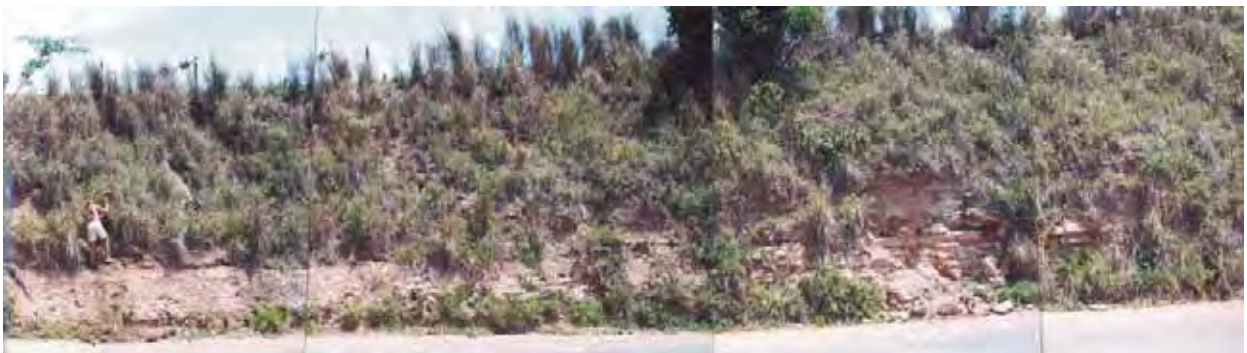
FIGURA 22. VISTA DO AFLORAMENTO LOCALIZADO NA RODOVIA ÍVENS VIEIRA, KM 1,2.
