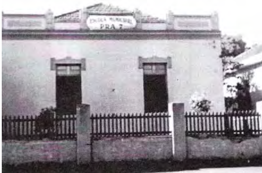
FIGURA 20 – FACHADA DA ESCOLA MUNICIPAL PRA-7
