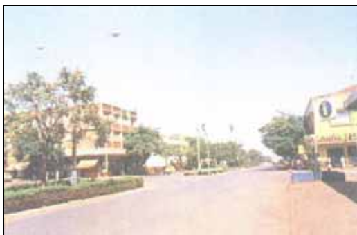
FOTOGRAFIA 8 - Ruas asfaltadas e arborizadas
