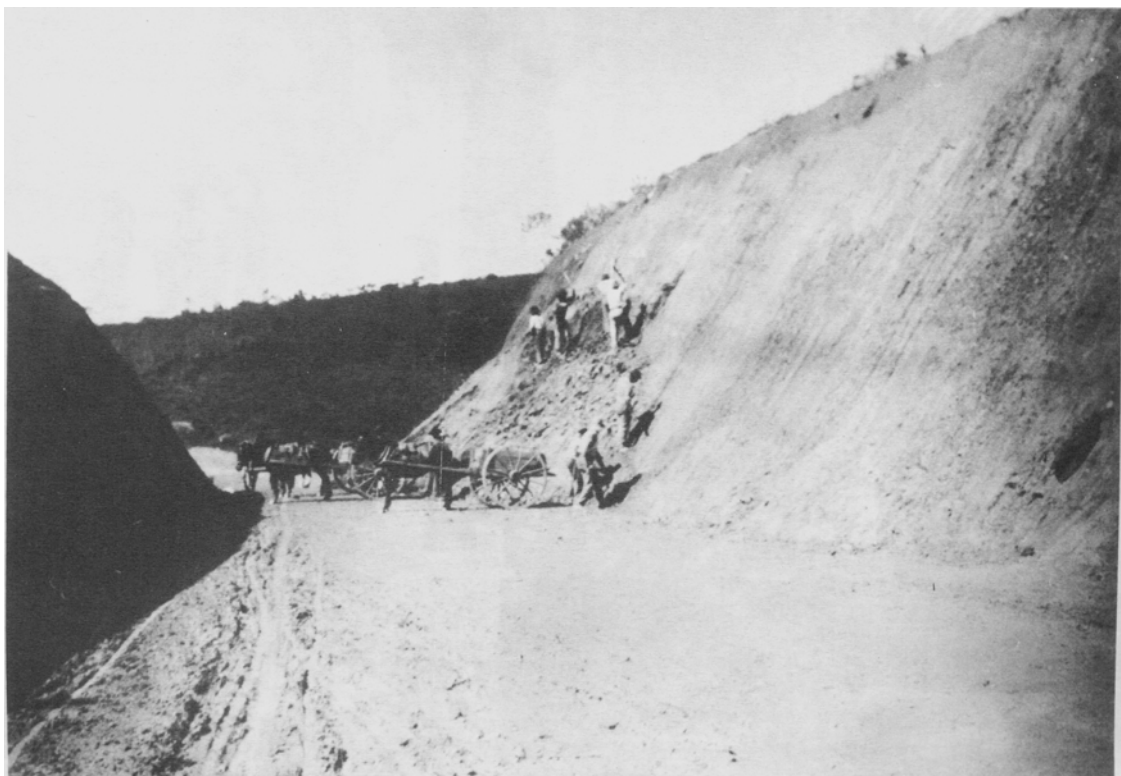
Figura 12 – Construção de estrada de rodagem. Abertura de corte na serra d’Água. Observe-se a precariedade dos meios de que se dispunha para a realização das obras. Fonte: DEBES, Célio. Washington Luis: primeira parte (1869-1924) . São Paulo: Imprensa Oficial do Estado de São Paulo, 1994, p.260.
