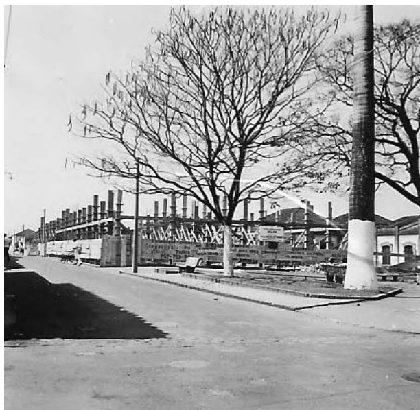
Figura 5: Obras de ampliação, 1959.
