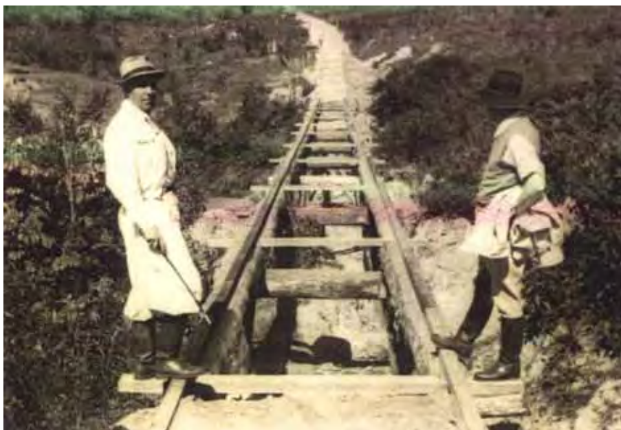
Fig. 13: “Madeirovia”. Na falta de trilhos de ferro, trilhos de madeira, em Indiana, SP. Fonte: Acervo digital. Centro de Memória Jindrich Trachta. Batayporã, MS.
