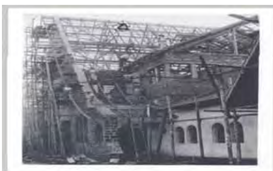
Figura 31 - Construção da 2ª Estação Ferroviária 182
