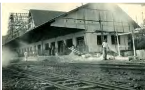
Figura 32 - Construção da 2ª Estação Ferroviária [194] 183
