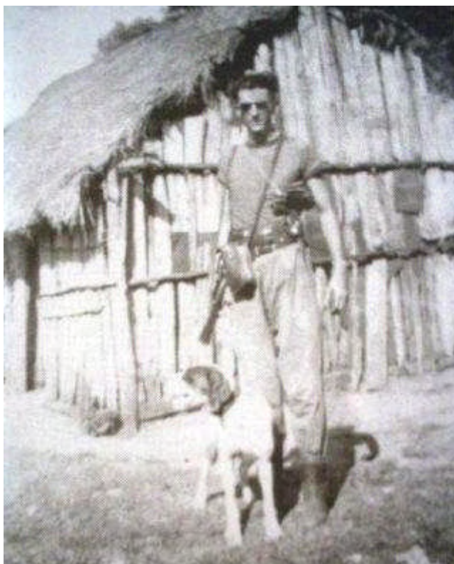
Casa de Pau-a-pique construída pela iniciativa dos próprios colonos.
