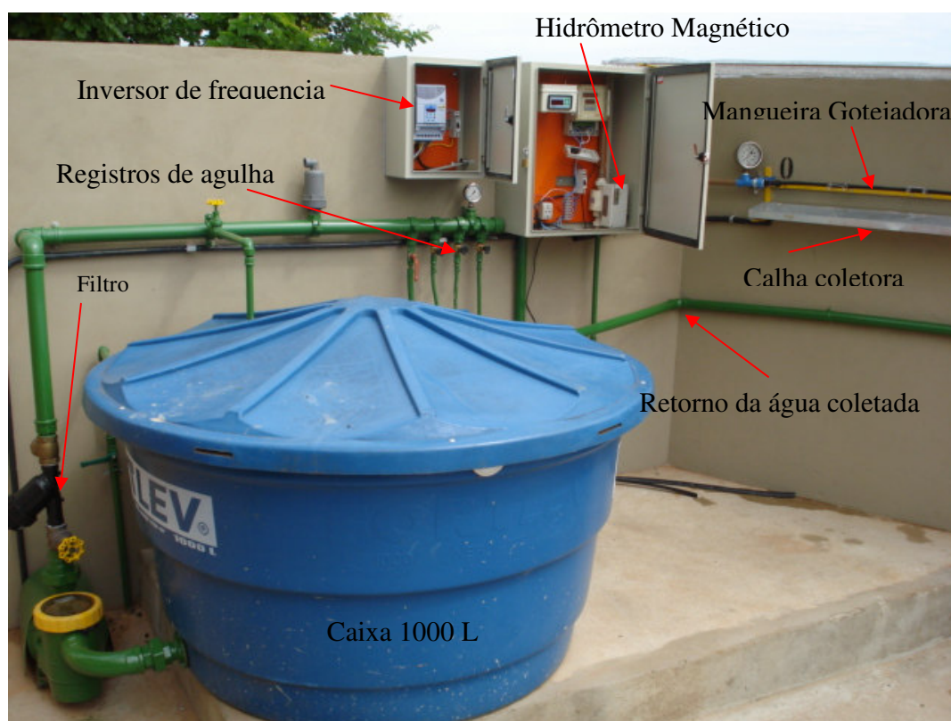
Figura 11. Central de controle do Laboratório de controle de qualidade da Petroisa Irrigação Ltda.
